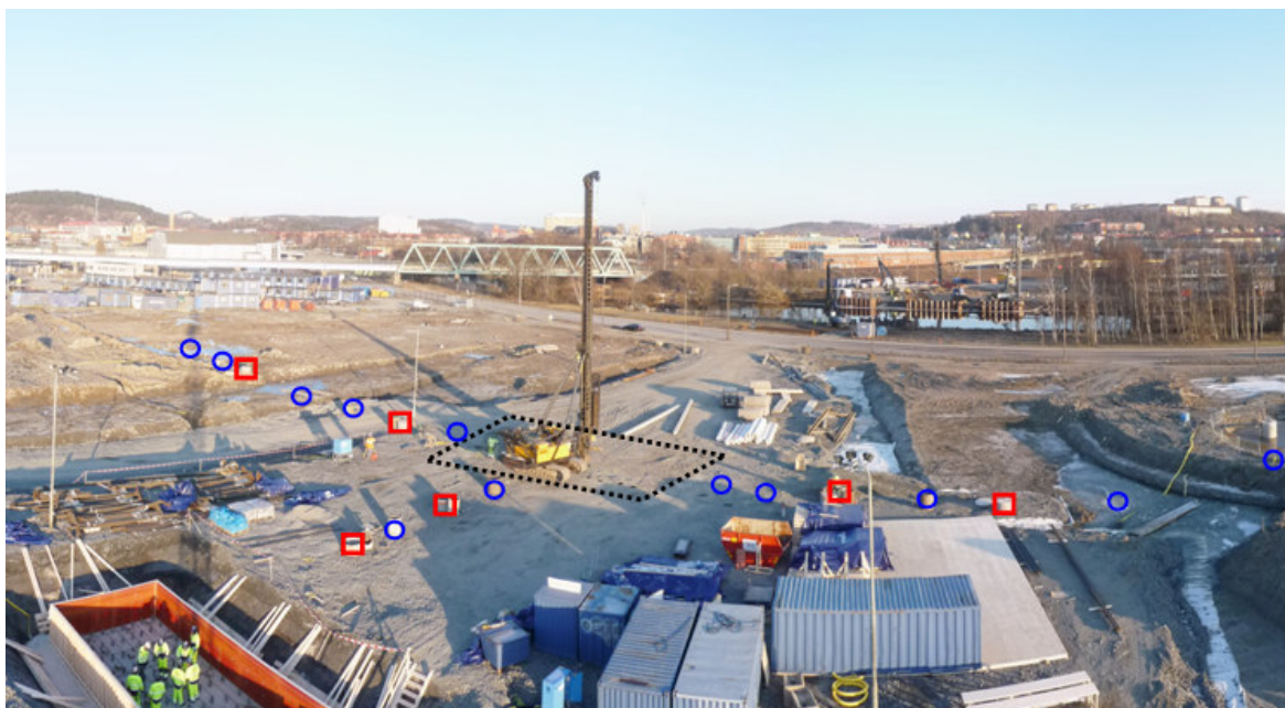
Figur 4. Vy över fältmätningarna vid påslagning för brostöd A11. Till vänster i förgrunden syns gjutformen för brostöd A10. Cirkelsymboler=lägen för markpeglar Kvadratsymboler=lägen där såväl markpeglar, inklinometrar som bäglslangar installerats.
